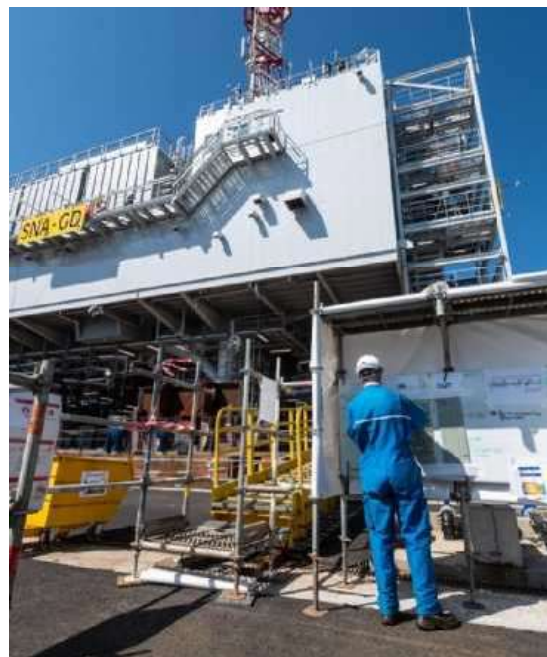
La sous-station de la centrale éolienne en mer du parc de Saint-Nazaire, un petit immeuble de 2 000 tonnes. XAVIER LEOTY
