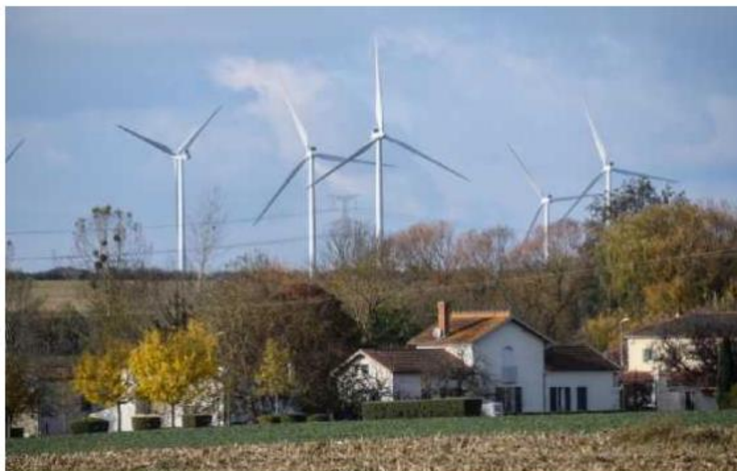
Éoliennes, panneaux solaires, méthaniseur... La production d'énergies renouvelables sur le territoire doit accélérer selon l'élus : « si on ne le fait pas, on nous le reprochera ». X. LÉOTY
