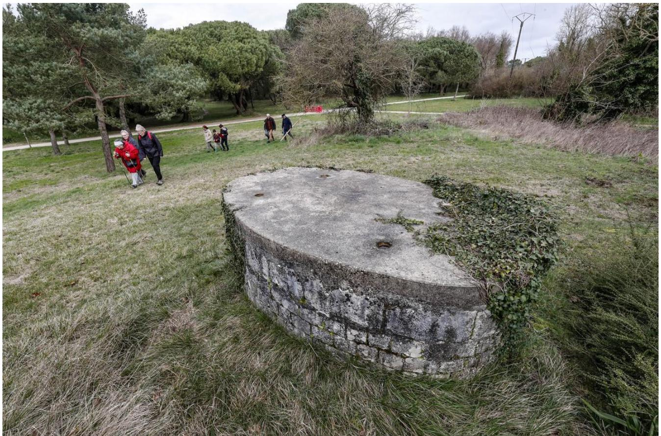
L'une des deux cheminées d'aération du tunnel, qui émerge de la colline Saint-Léonard, a été bouchée par une dalle en béton.
